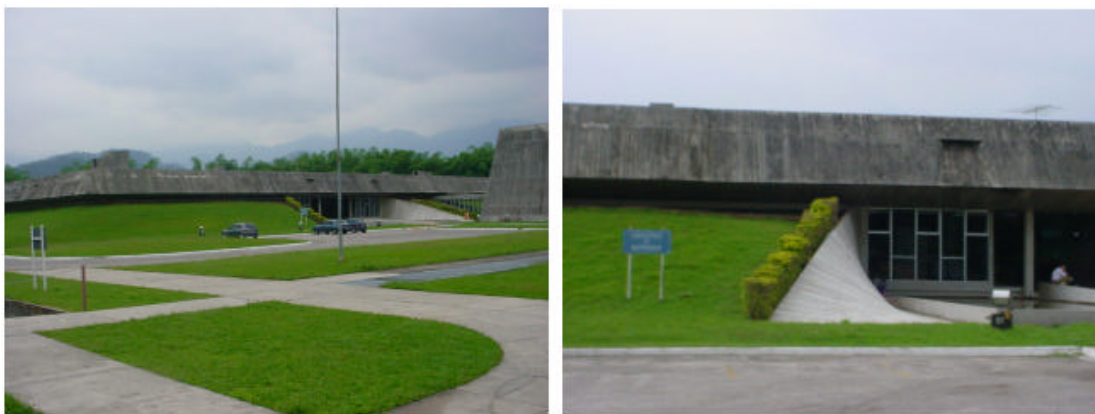
Figura 4.7 - Vistas do Prédio da Divisão de Metrologia Elétrica
